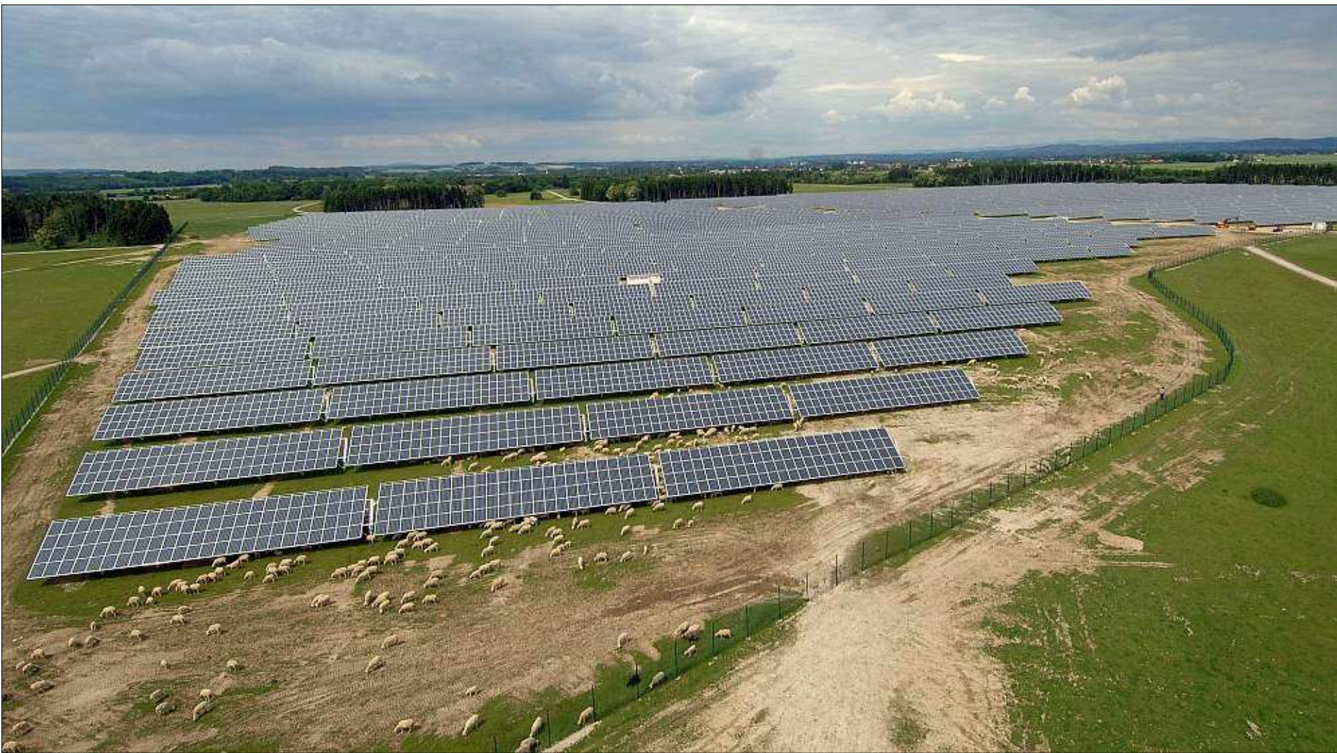
So sieht er aus, der Solarpark im ehemaligen Bundeswehrgelände. Westlich davon soll ein neuer entstehen, der die gleichen Dimensionen hat. – Foto: Jörg Schlegel
